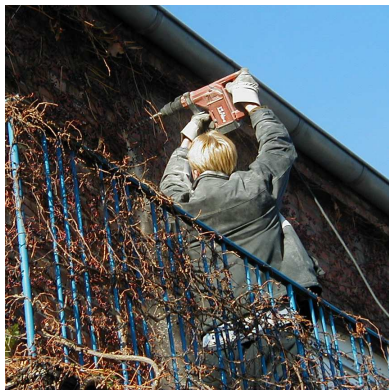
Openingen boren met een diameter van 25 mm
