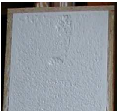
Leidingenzone 40 mm van een houtskeletbouwconstructie, geïsoleerd met SLS®20F.
