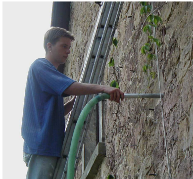
Inblazen van een spouwmuur achter een gevel in natuursteen.
