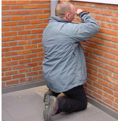
Controle van de spouwmuur met de endoscoop
