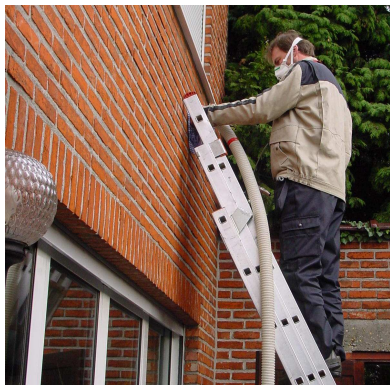
Isolatie van de spouwmuur met SLS®20F.
